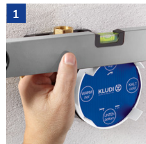
Upevnenie podomietkového telesa.
