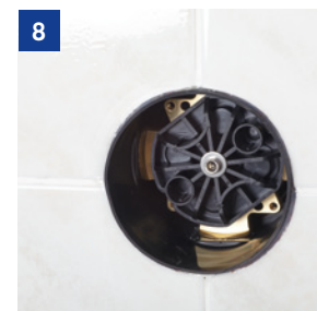
Odstránenie preplachovacieho modulu.
